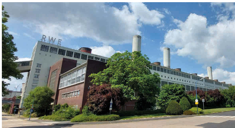
Turbinenhalle Kraftwerk Frimmersdorf – industrielle Folgenutzung oder bald Industriemuseum? // Foto: DGB-Region NRW Süd-West
