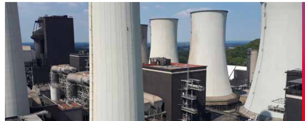
Kühltürme und Anlagen des Uniper-Kraftwerks Scholven bei einer Betriebsbesichtigung des DGB am 24.07.2018 Bild: Mark Rosendahl
